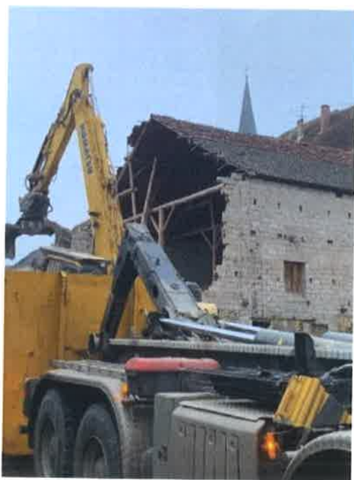
Démolition des étables, décembre 2020.
