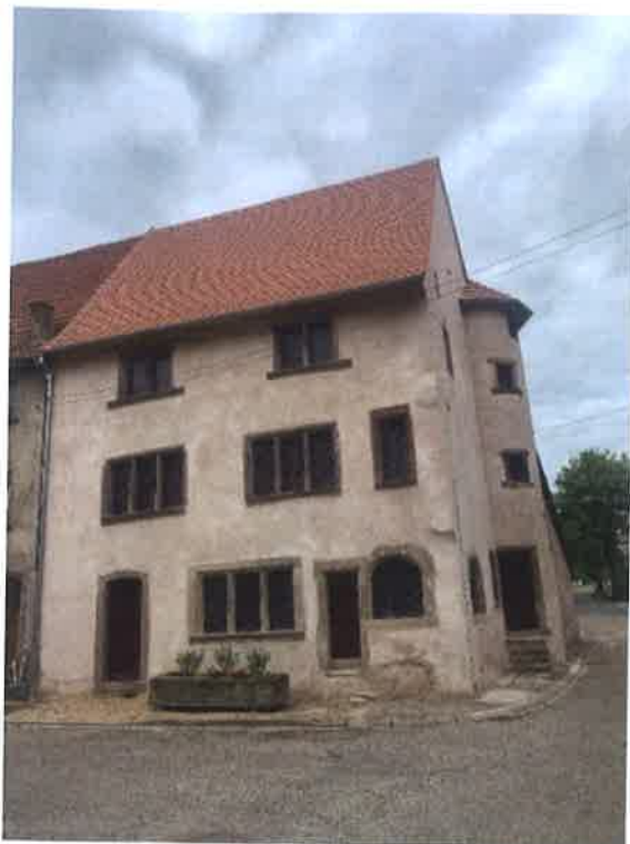
Magasin médiéval après rénovation : une opération exemplaire sur du bâti renaissance avec une façade réhabilitée selon ses origines, des meneaux et appuis reconstitués à l'identique en grès de taille. Les huisseries ont été réalisées en bois peint et des vitraux reconstitués d'après un modèle retrouvé dans l'ancienne tour d'accès. Une réalisation qui a permis de sauver ce bâti en péril imminent et qui montre encore le chemin de ronde.
