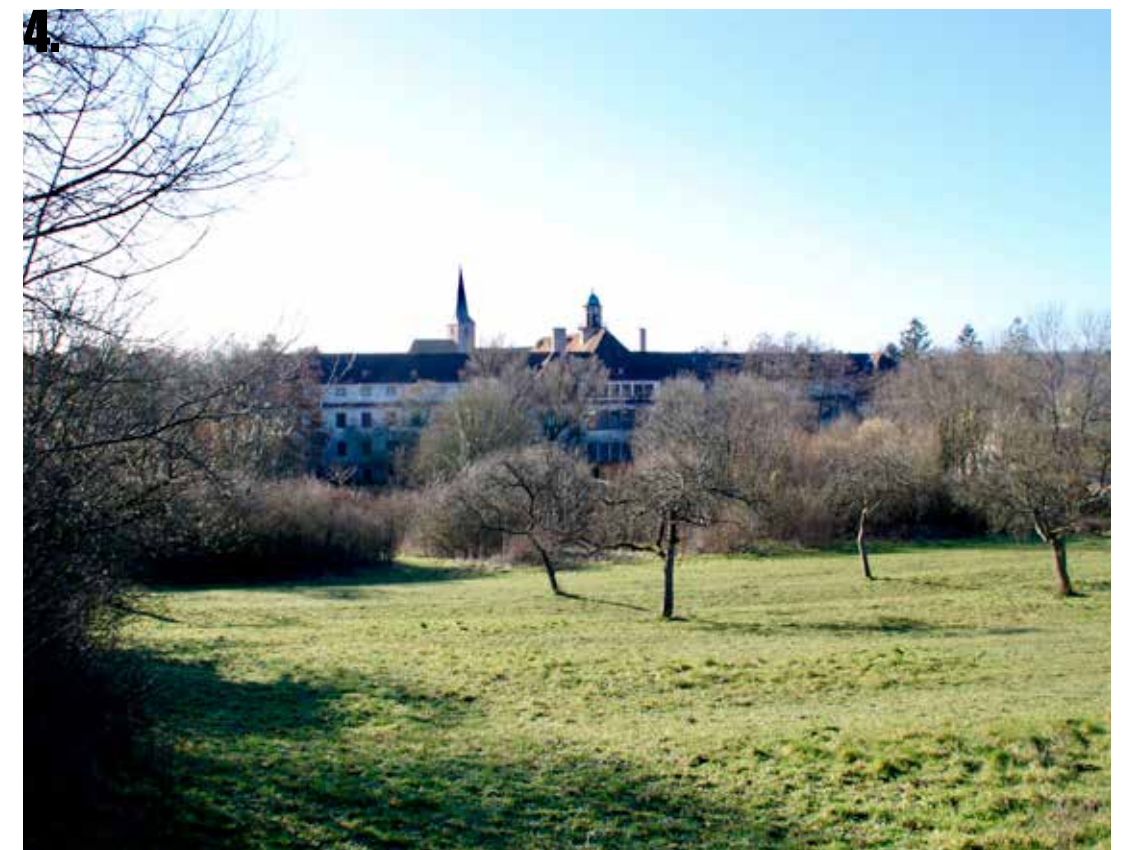
4. Vue du pensionnat depuis la D43 en direction de Fénétrange.
